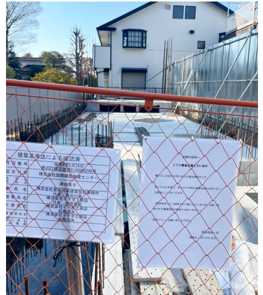
▲東京農工大学隣に位置する 「教会」施設建設現場(24年4月撮影)
