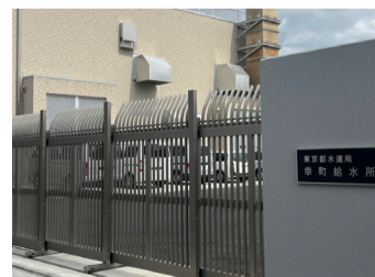
▲今年 3 月に改修工事が完了した幸町浄水場
